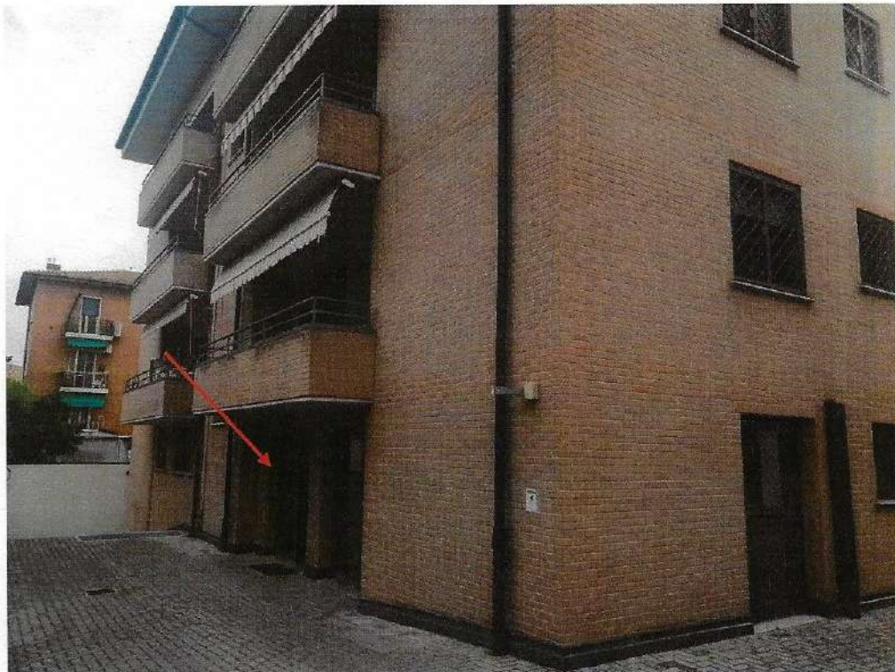
2 - ingresso al condominio
